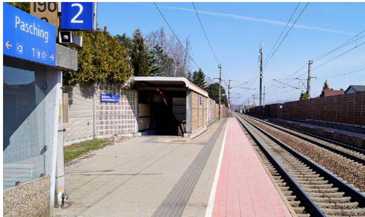
Die Zukunft der Bahntrasse in Pasching ist derzeit noch eine unklare.
